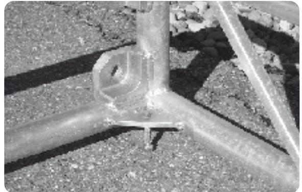
Nach dem Ausrichten der Traversen, können diese endgültig fest miteinander verschraubt werden.
