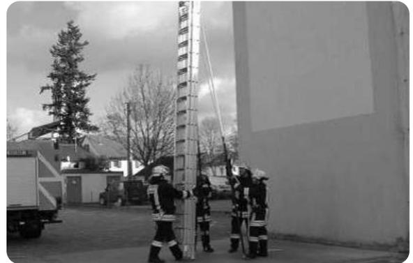
Die vierte Person löst das Zugseil und zieht die Leiter auf die erforderliche Höhe aus. Um die Leiter in der gewünschten Höhe zu fixieren, müssen die Fallhaken über die jeweilige Sprosse der Leiter gezogen werden. Leiter langsam zusammenfahren lassen, bis dass die Fallhaken hörbar auf den Sprossen zum Aufliegen kommen.
