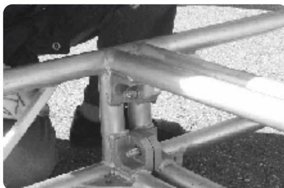
Ziehen Sie die Schraube jedoch nur soweit an, dass Sie die Traversen an den Flanschplatten noch etwas verschieben können. Richten Sie die gesamte Konstruktion mit einer Wasserwaage aus.
