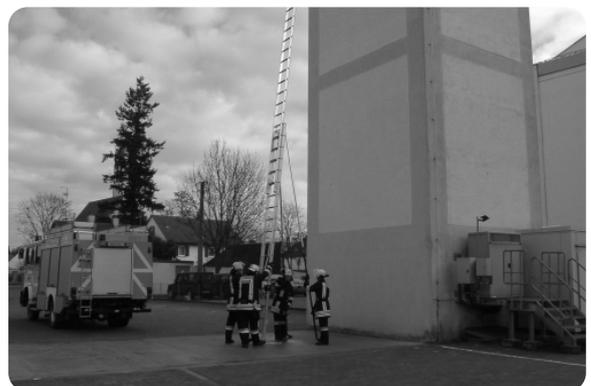
Leiter langsam zusammenfahren lassen, bis dass die Fallhaken hörbar auf der Sprosse zum Aufliegen kommen. Prüfen, ob die Fallhaken ordnungsgemäß aufliegen.
