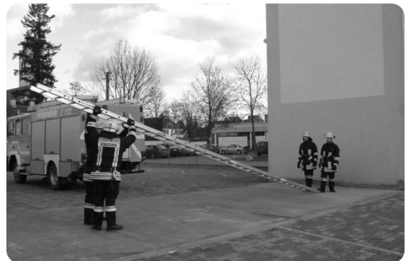
Die zusammengesteckte Leiter kann auch an die Wand des Objektes geschoben werden. Die beiden Personen an den Leiterfüßen sichern die Leiter.
