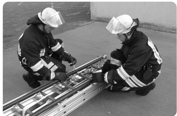
Zwei Personen nehmen die Stützstangen auf und sichern den Leiterfuß. Zwei weitere Personen am Leiterkopf richten die Leiter auf, wobei die beiden Personen an den Stützstangen durch Ziehen das Aufrichten unterstützen.
